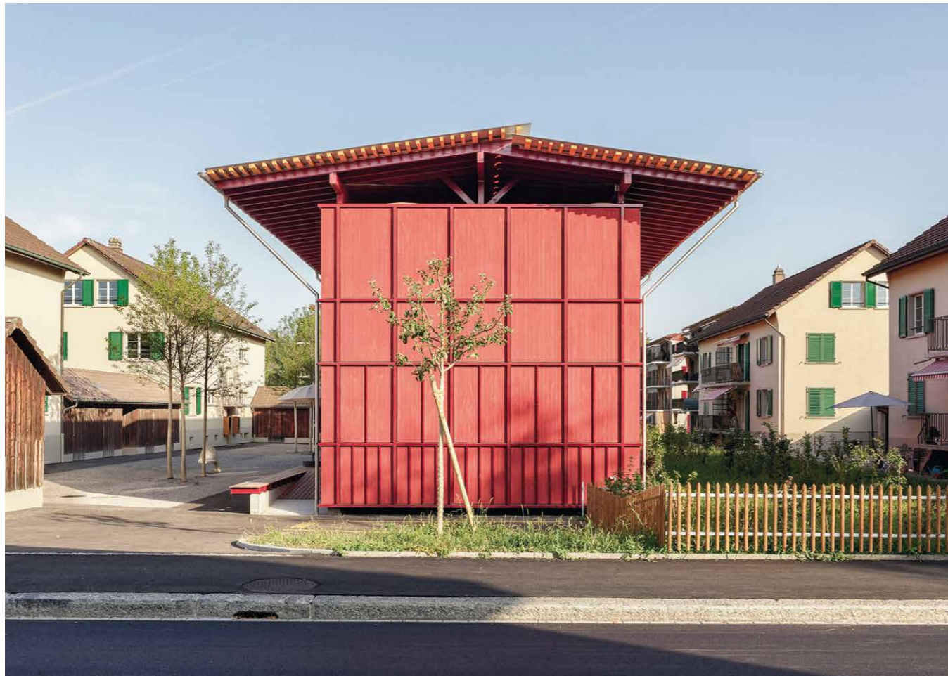
Bauherrschaft Wohnbaugesellschaft Langeten AG; Architektur Rolf Mühlethaler Architekten AG, Bern; Holzbau Hector Egger Holzbau AG; Bauingenieurwesen Idermühle Bauingenieure GmbH, Thun; Haustechnik Häusler Ingenieure AG; Fertigstellung 2023; Adresse Pappelweg, 4900 Langenthal; Architekturfotografie Alexander Gempeler, Bern
